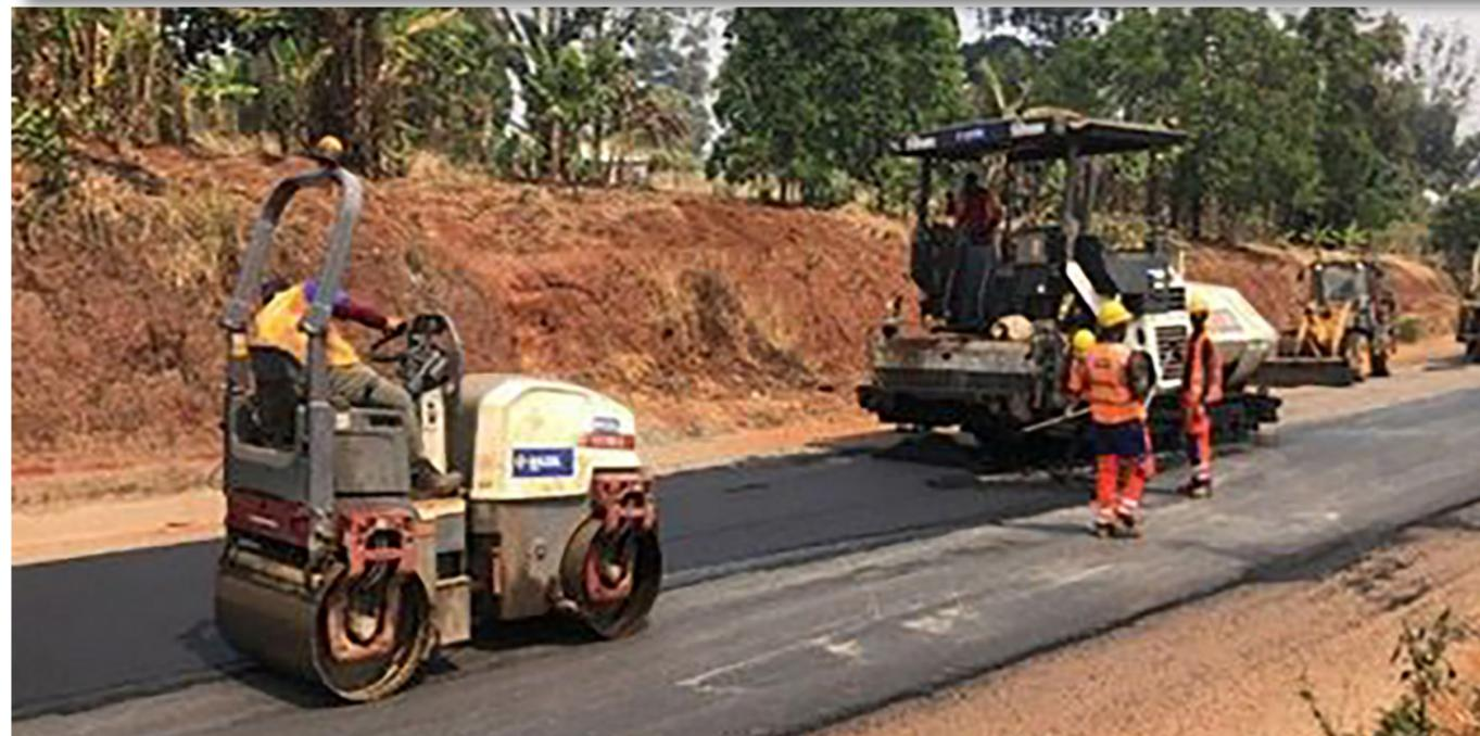
Tronçon Mbouda-Batcham le 31 Janvier 2025. L'état des travaux avec ma mise en œuvre du béton bitumeux
